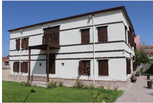
Şekil 24. Tartan Konağı'nın günümüzdeki durumu
