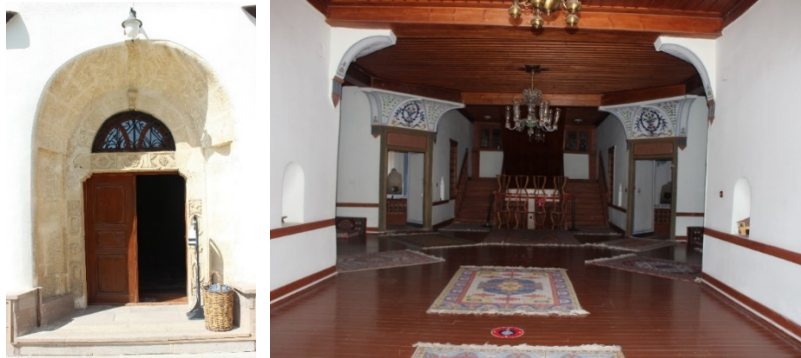
Şekil 25, 26. Tartan Konağı giriş kapısı ve giriş kapısından sofa, oda kapıları ve merdiven görünümü
