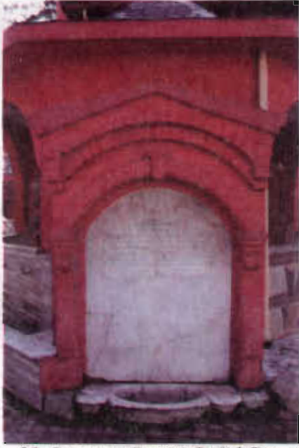
Resim 23. Sapanca Cami-i Cedid Çeşmesi ön cephesi
