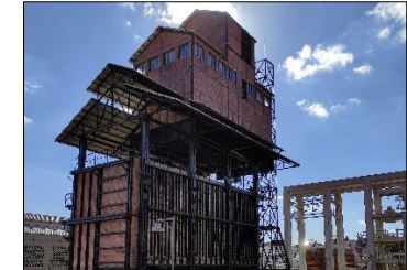
(c) M Binası Fırın
