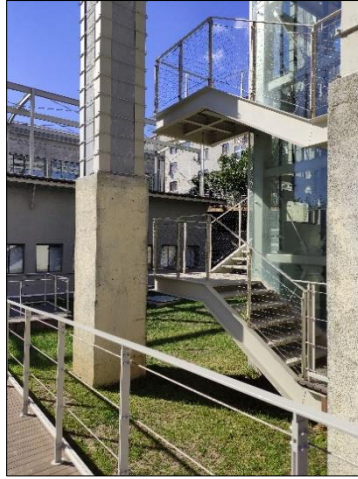
(b) Güney Doğu cephesi
