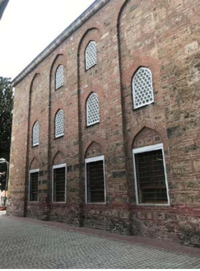
Görsel 7 Üftâde Camii'nin doğu cephesinde pencere dizilimleri
