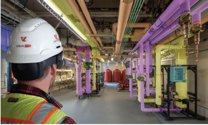
Şekil 4 - Yapı üretimi aşamasında BIM-VR entegrasyonu ile MEP kontrolleri (VisualLive, 2023)
