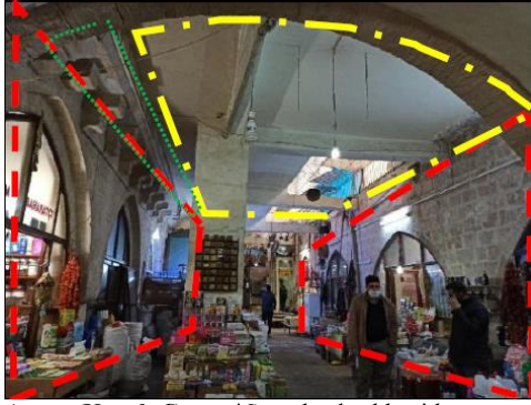
Arasta Kapalı Çarşısı: *Sarı alanda eklenti betonarmeler kaldırıldığında iç avlulu, sağda ve solda dükkanlar görülmektedir.*Kırmızı alanlar dükkan olduğu görülmektedir.*Yeşil alanlar; Taş bingi ile üst katta gezinti alanı oluşturulmuş.
