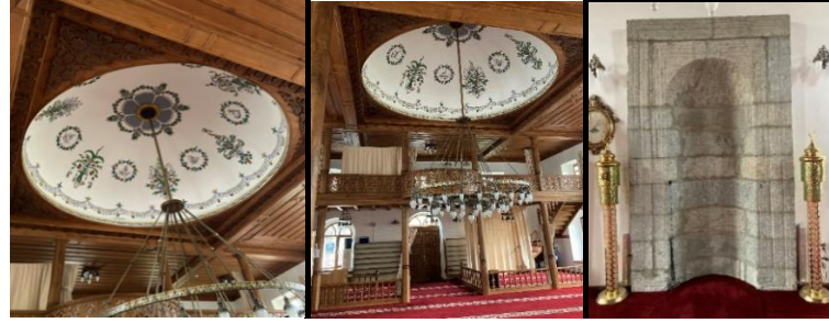
Şekil 37. Orta Hopa Camii’nin bağdadî kubbesi (Çakıroğlu 2022)
