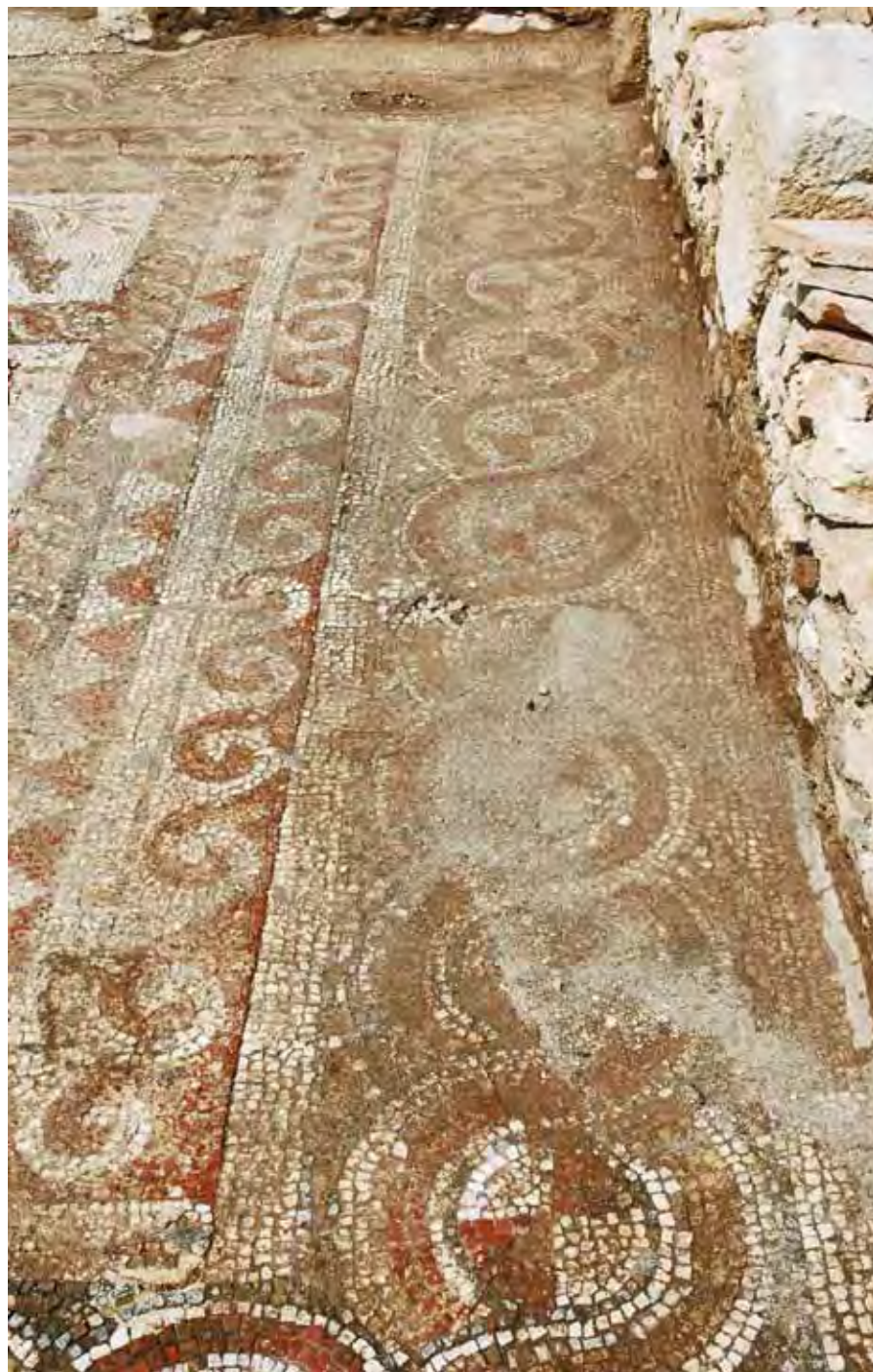
Figure 1 Byllis, basilique E. Joint séparant des phases de travail, à droite de la ligne de postes (ph. M.-P. Raynaud)
