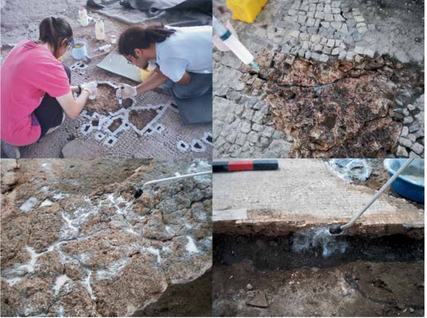
Resim 7 Mozaik harcı üzerindeki çatlaklara yapılan Primal AC 33 Uygulaması
