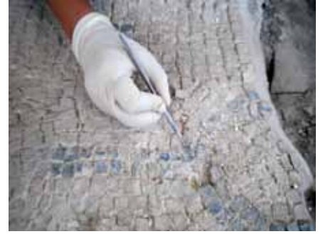
Resim 6 Yüzey ve Derz Temizliği
