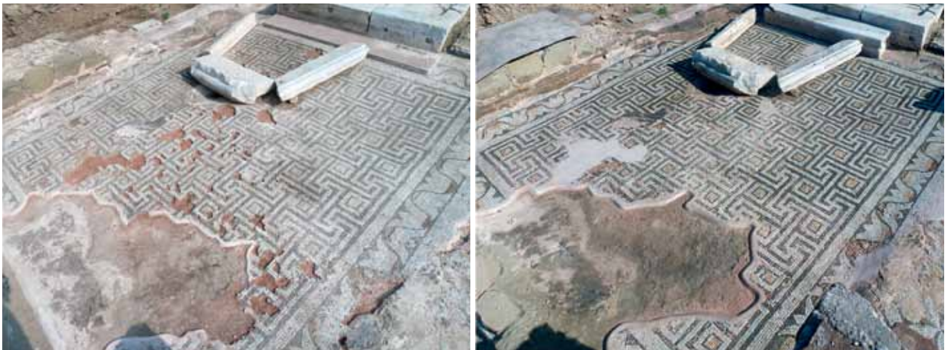
Resim 5 İç narteks döşemesindeki tümleme uygulaması
