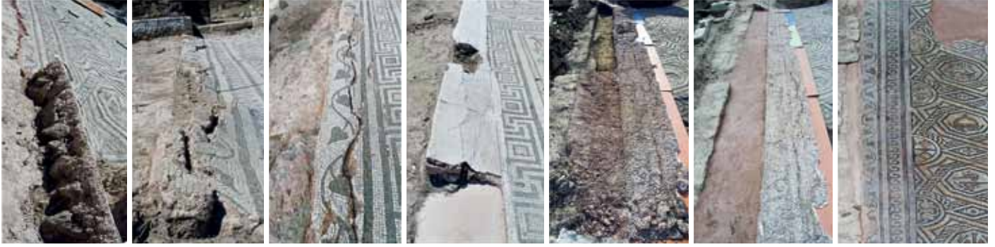
Resim 2 Kuzey nefte dikey deformasyonların onarımı.
