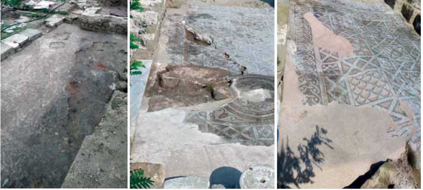
Resim 7 Dış narteks döşemesindeki dikey deformasyonun onarımı
