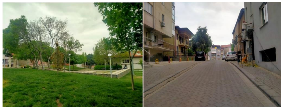
Şekil 12: 958 sokak mevcut görünüm
