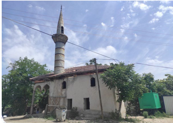
Görsel 2. Şeyhler Cami batı cephesi
