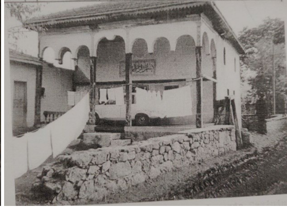
Görsel 21. Şeyhler Cami kuzey cephesi,1992 (Samsun Koruma Bölge Kurulu arşivi)
