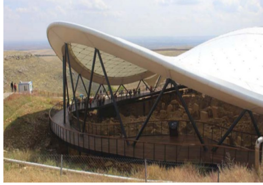
Fig. 19. Göbeklitepe Koruyucu Çatısı (İrepoğlu 2019, 22)
