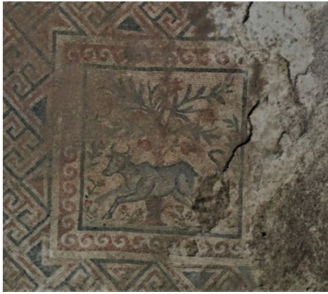
Fig. 3a. Mozaik Tabakalar Arası Ayrışmadan Kaynaklı Yükseklik Farkı
