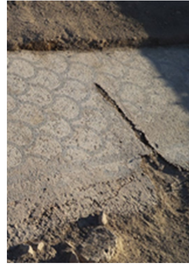
Fig. 1. Sol Nef Mozaiginde Çatlak Görünümü
