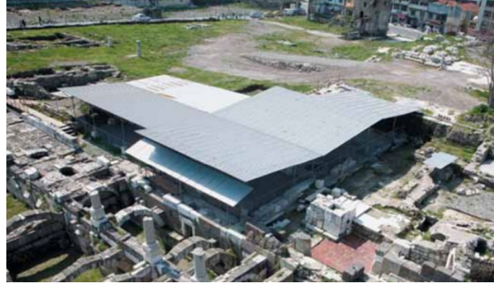
Fig. 20. Smyrna Agorası Koruyucu Çatısı (Ersoy & Yolaçan 2012, 74)
