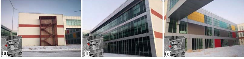
Şekil 5. Bina cephesi: (a) Doğu-Batı cephesi, (b) derslik cephesi (Kuzey), (c) koridor cephesi (Güney) (Building façade: (a) East-West façade, (b) classroom façade (North), (c) corridor façade (South))
