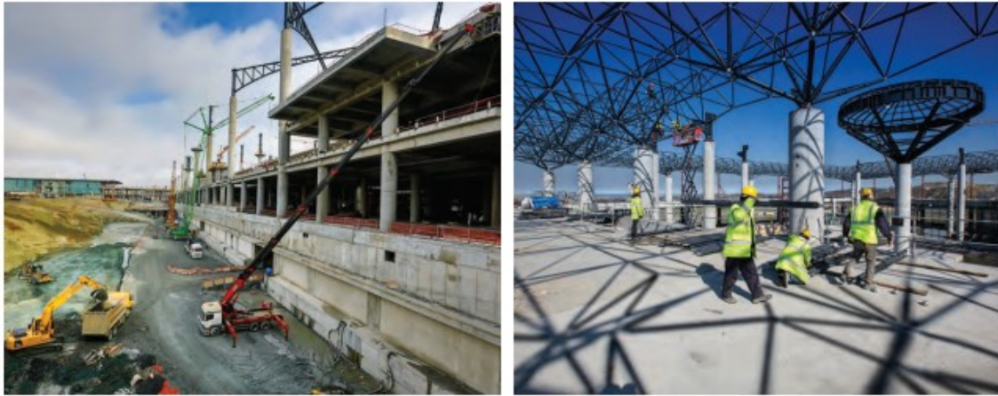
Şekil 9. Havalimanı terminali inşa süreci (Şengül ve ark., 2022).
