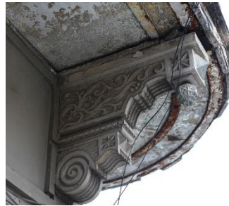
Foto. 12-14. 1. kat çıkma ayrıntısı; çelik kiriş, taş konsol, kat silmesi ayrıntıları
