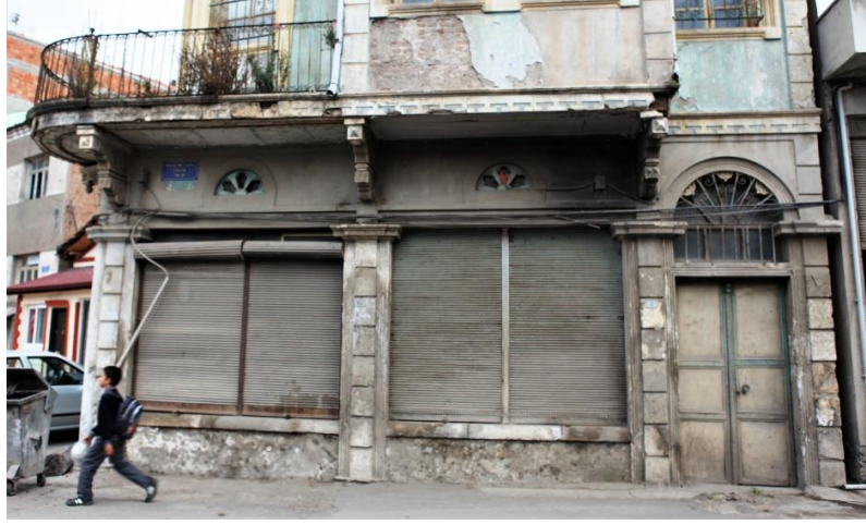
Foto. 6. Ön cephe zemin kat (2013 yılı)
