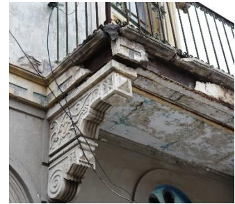
Foto. 12-14. 1. kat çıkma ayrıntısı; çelik kiriş, taş konsol, kat silmesi ayrıntıları
