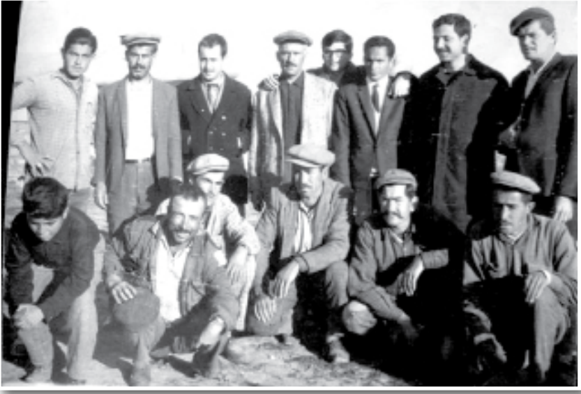
Fotoğraf 3 Ayaktakiler (solda) Sahir Koçak, Korkmaz Alemdar, Nurettin Sarıdar, Böyler Köyü Muhtarı Halil Tak
