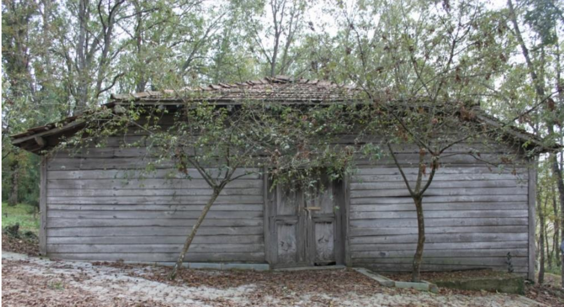
Şekil 12. Camii kuzey cephesi, restorasyondan önce (Kahraman ve Boduroğlu, Ekim 2015)
