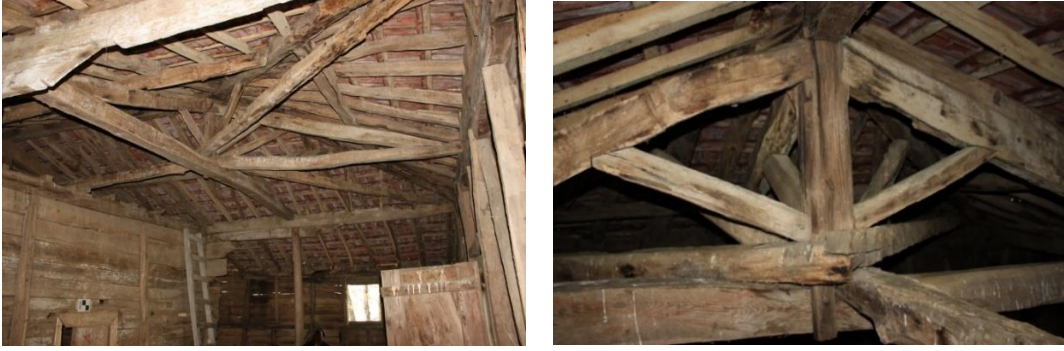
Şekil 16. Son cemaat mekânı çatı makası sistemi (Kahraman ve Boduroğlu, Ekim 2015)
