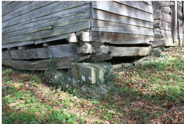
Şekil 17b. Taş pabuçlar üzerinde birbirine kertilerek mesnetlenmiş kirişler (Kahraman ve Boduroğlu, Ekim 2015)
