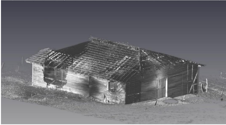
Şekil 7. Işıklı Camiinin 3D Scanner datasından elde edilen perspektifi (Kahraman ve Boduroğlu, 2016).
