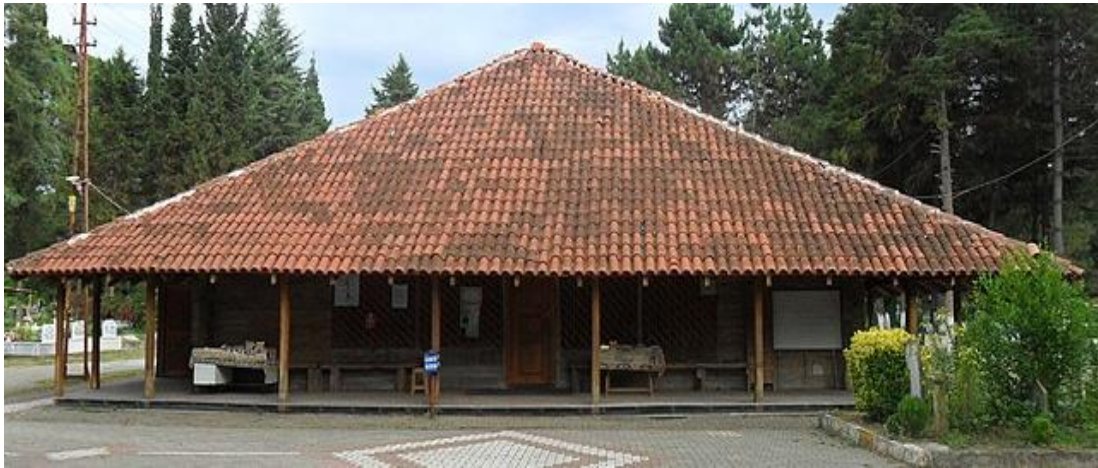
Şekil 3. Samsun Gökçeli Camii dış cephesi ve revakları (URL-2)
