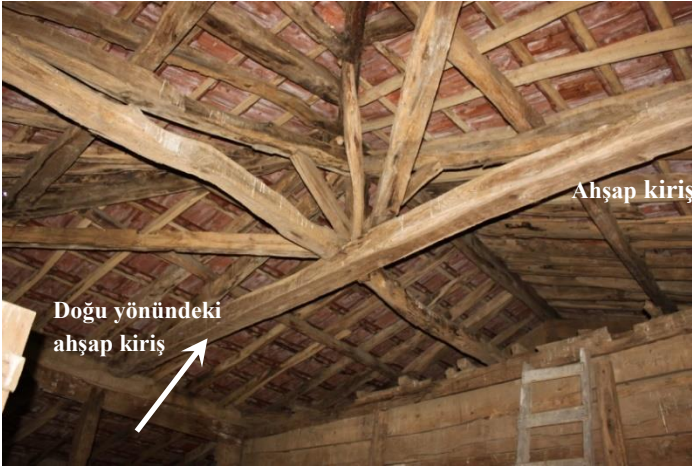
Şekil 22. Işıklı Camii son cemaat yeri çatı makası
