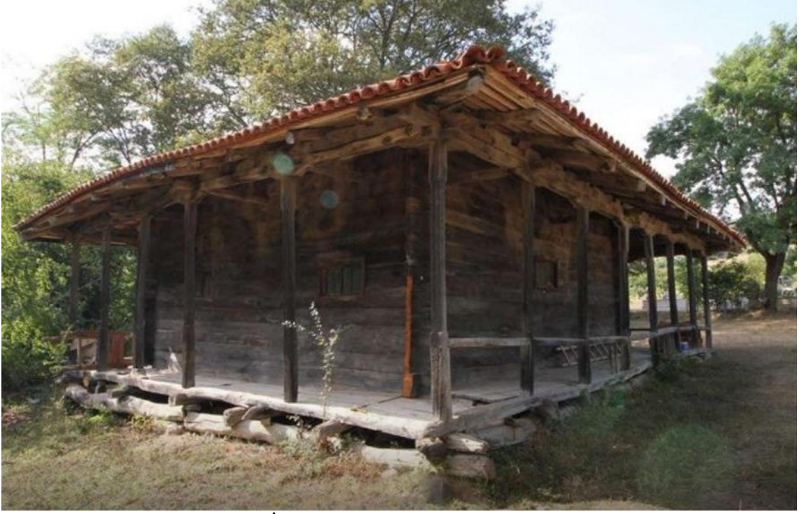
Şekil 21. Samsun Kavak İlçesi Değirmencili Köyü Dere Camii Revakları (URL-3).
