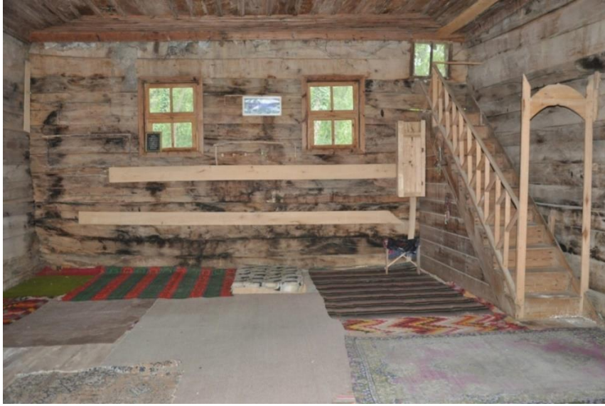
Şekil 10. Restorasyondan önce harim güney (mihrap) duvarı (Kahraman ve Boduroğlu, Ekim 2015)
