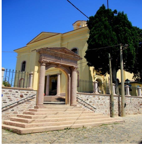
Şekil 9 Alibey/Cunda Adası'ndaki Taksıyarhis Kilisesi'nin restorasyon sonrası dış cephe görüntüsü
