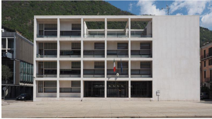
Şekil 1: Casa del Fascio (1932-1936)
