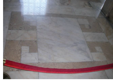
Fot. 14: Galerilerde açıklıkların zeminini.
