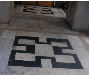
Fot. 28: Sağıdaki galerinin 8 ve 9. bölüm zemini.
