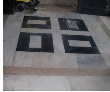
Fot. 15: Soldaki galerinin 1. bölüm zeminini.
