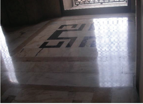
Fot. 17: Soldaki galerinin 4. bölüm zeminini.
