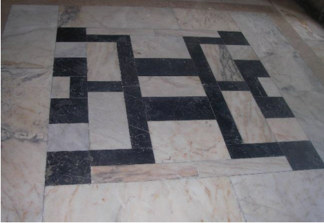
Fot. 19: Soldaki galerinin 7. bölüm zeminini.
