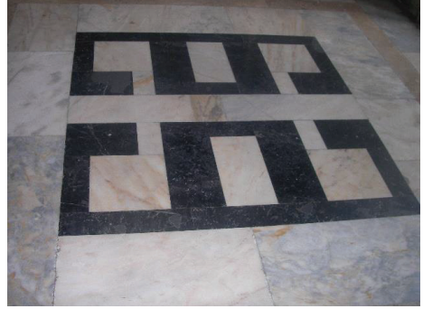
Fot. 18: Soldaki galerinin 6. bölüm zeminini.
