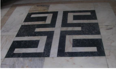
Fot. 26: Sağıdaki galerinin 6. bölüm zemini.
