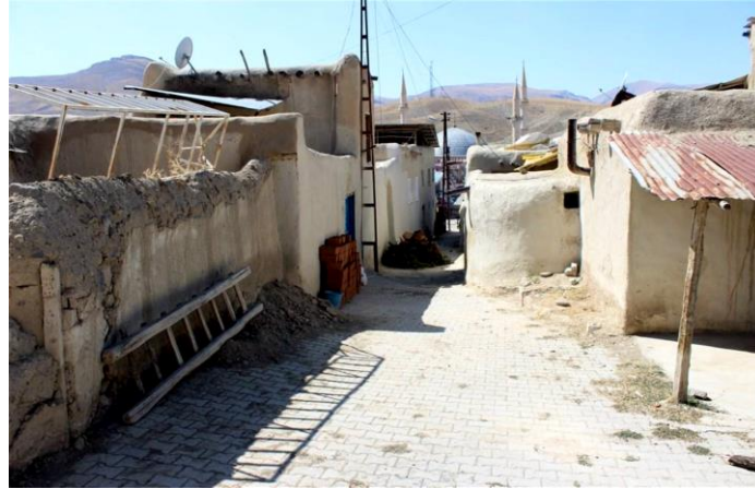
Foto 2d. Erdem sokak evleri doğu cephe (Photo 2d. Erdem street houses the eastern front)
