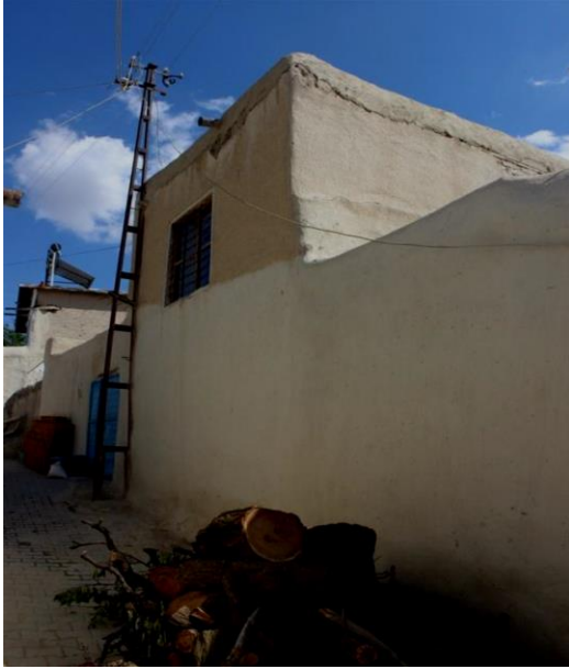
Foto 2f. Kuzeybatı cephe (Photo 2f. Northwest front)
