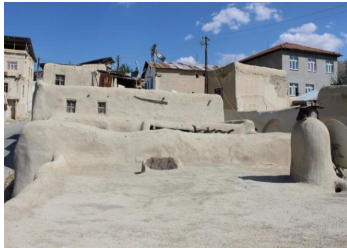
Foto 3ı. Toprak dam (Photo 3ı. Soil roof)
