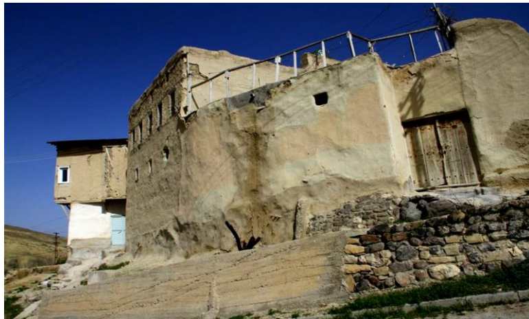
Foto 1c. Güneydoğu cephe (Photo 1c. Southeast front)
