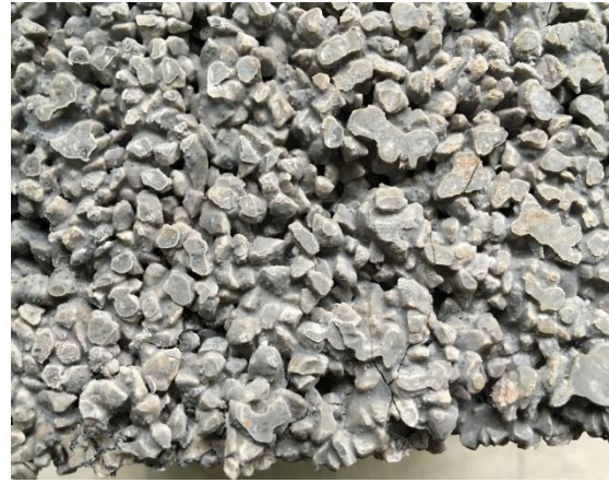
Şekil 1. Geçirimli beton yüzey görünümü
