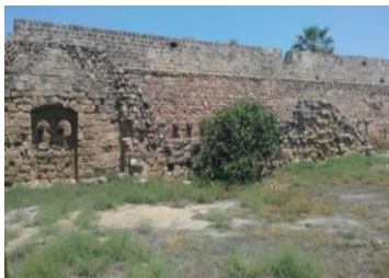
Şekil 20. Gazimagusa Kaleiçi duvarındaki yüksek bitki tahribatı
