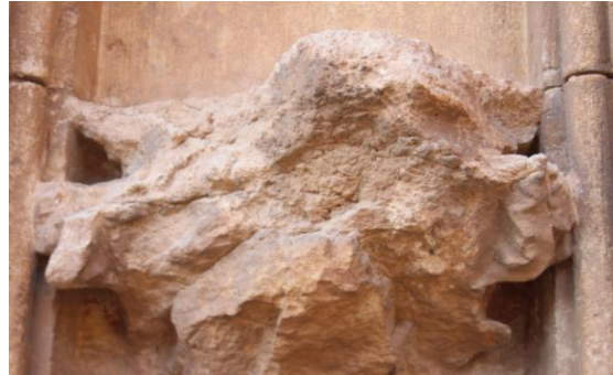
Şekil 18. Gazimağusa Kaleiçi Lala Mustafa Paşa Camiisi giriş cephesindeki yapı taşlarında görülen tozlanmalar
