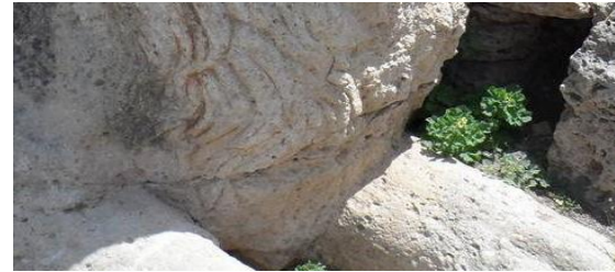
Şekil 4. Gazimağusa Kaleiçi Çarşı Merkez aslan heykeli alt boyun kesimindeki çatlak
