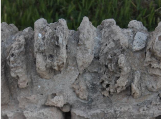
Şekil 14. Gazimağusa Kaleiçi kale surları ön cephesindeki yapı taşlarında tuz etkisi ile oluşmuş yüzeysel erozyonlar
