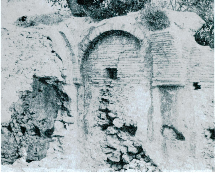
Res. 35 — Revakların arka duvarları ve tuğla kemer ve kubbe kalıntıları.
