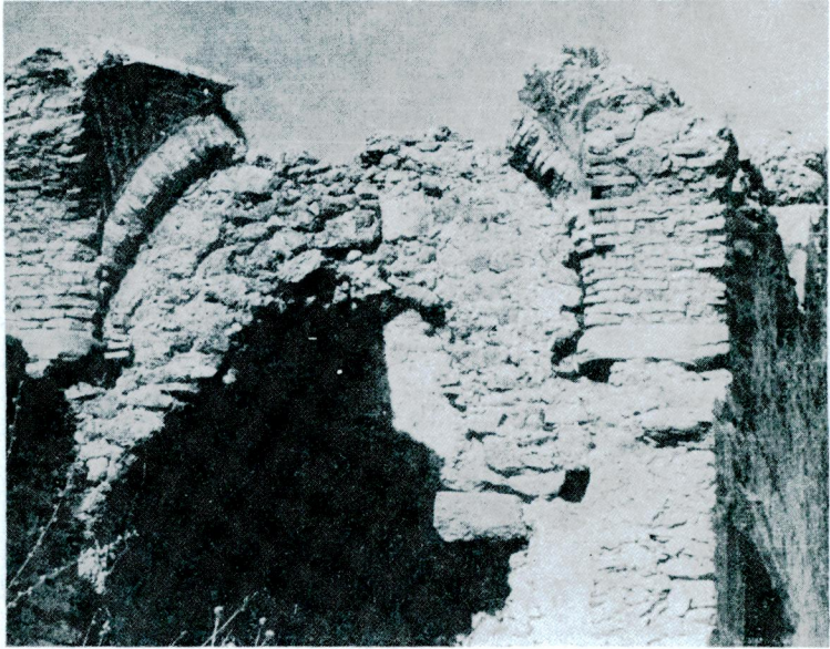
Res. 36 — Revakların yan odalarından birinin cephesi. Solda revak kubbelerinden birinin pandantif parçası görülüyor.
