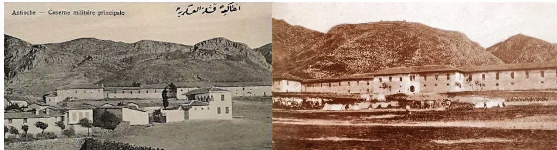
Şekil 7. Tarihi Kışla Yapısı (Demir, 1996, s. 93 ve Çılğın, 2019, s. 220)
