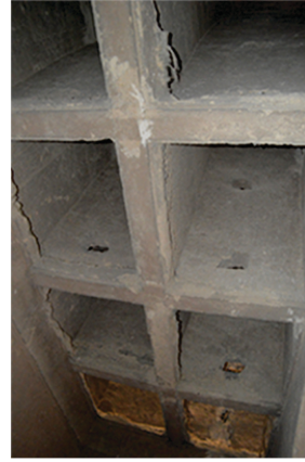
Rüzgâr baca odasına açılan baca kanallarının görüntüsü
