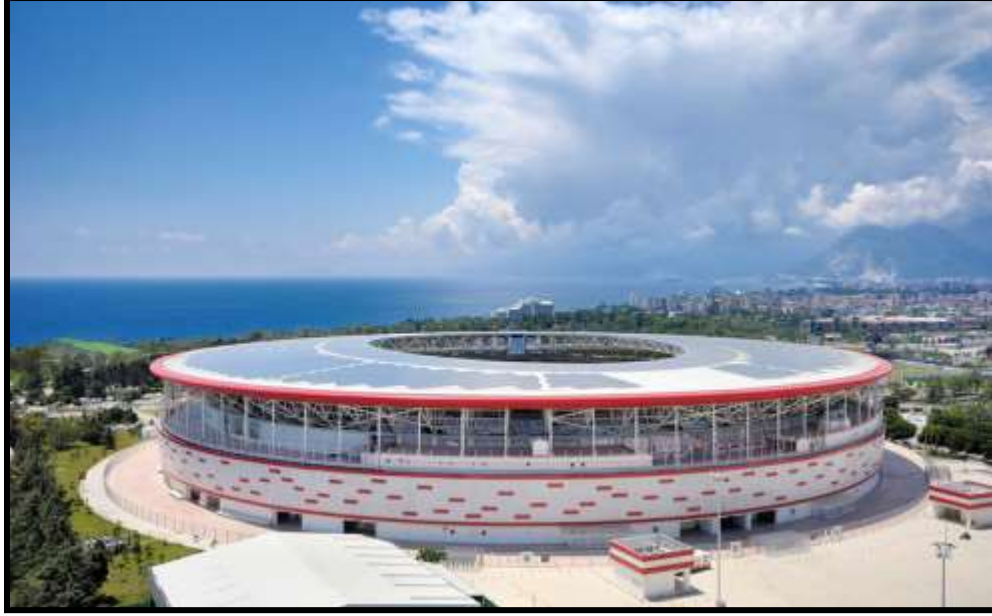
Şekil 9. Antalya stadı ve çatısında bulunan fotovoltaik güneş enerjisi panelleri (Antalyaspor, 2023)
