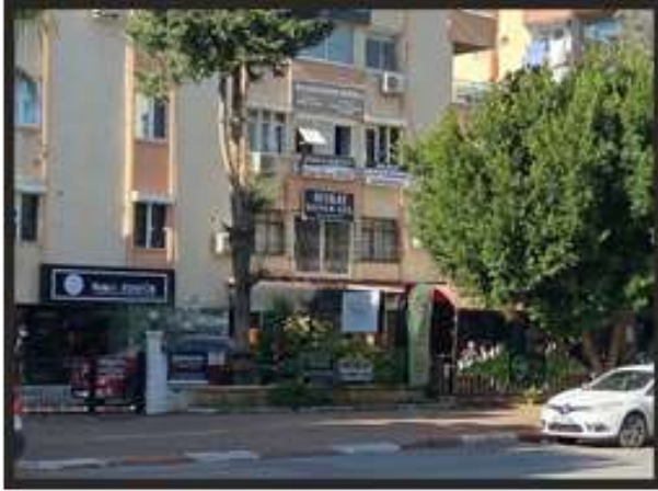
Şekil 5. Mahalledeki cephe ve girişler
