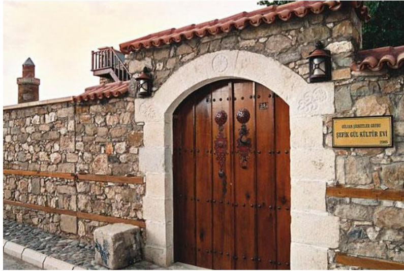
Şekil 2. Çift sıra ahşap hatılla örülmüş taş bahçe duvarı ve üzerinde düzgün kesme taş kemer bulunan ahşap kapı (Url-3).
