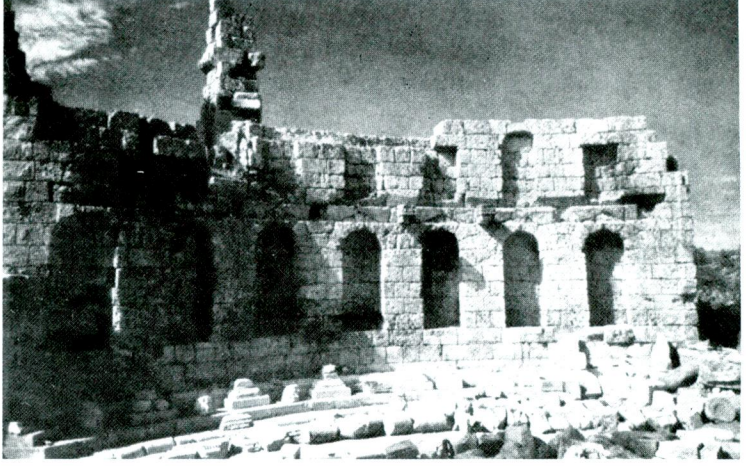
Res. 58 — Perge Şehir kapısı avlusu.
