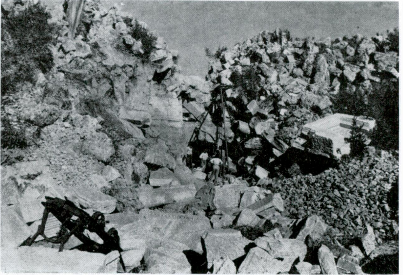
Res. 49 — Side. Tiyatronun skene binası kazılırken.
