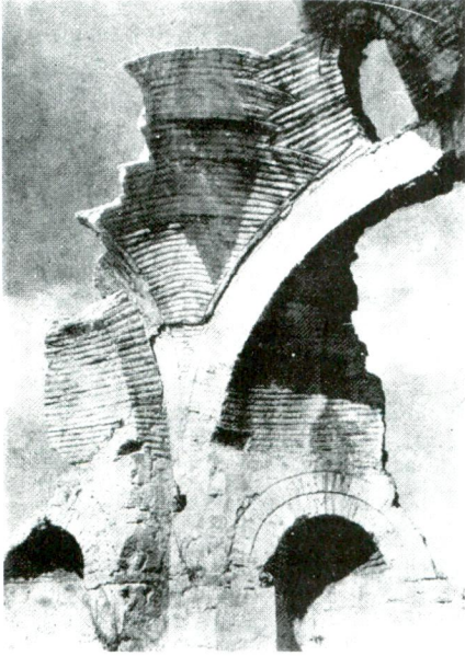
Res. 32 — Side. Aynı mausoleum'un kemer ve kubbe sistemi.
