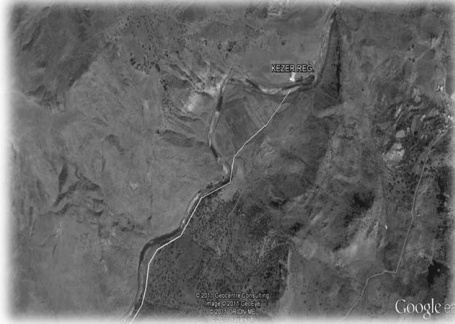
Şekil 2. Kezer regülatörü ve HES regülatör yeri ve iletim kanalı güzergahı uydü görüntüsü
