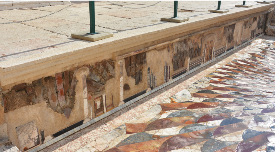
Fig. 6 Pulpitum cephesi opus sectile mimari dekorasyon, kuzeyden genel görünüm. (Kibyra Kazı Arşivi)
