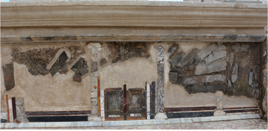
Fig. 7 Pulpitum cephesi opus sectile güney kapı betimlemesi. (Kibyra Kazı Arşivi)
