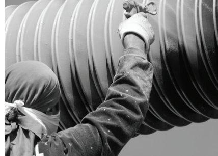
Şekil 10. Kaplama (havasız sprej kullanımı)
