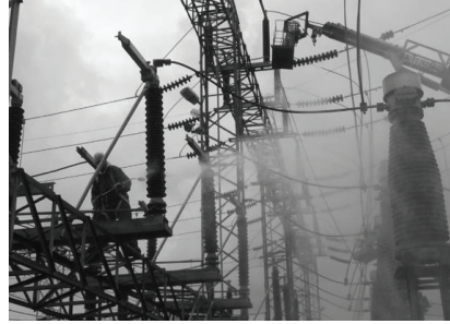
Şekil 8. Su jeti ile yıkama (600 bar)
