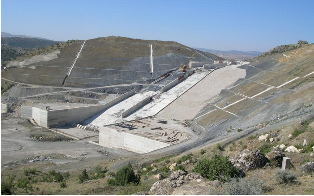
Şekil 8. Süreyyabey Barajı dolusavak kazı şevlerinin en son kazıdan sonra ve duvarların tamamlanmasına yakın hali
