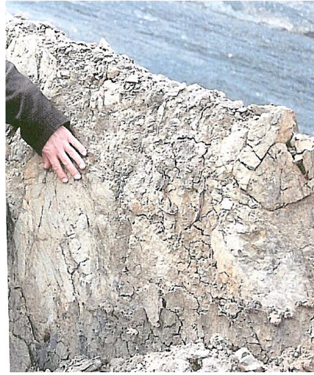
Şekil 3. Dolusavak kazı şevlerinin derivasyon tüneli çıkışına yakın bölgedeki hareketleri ve yakın planda ezilme zonu
