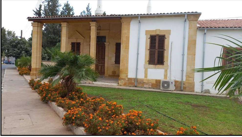
Görsel 2: Günümüzde Omorfo İbtidâî Mektebi Binası.
