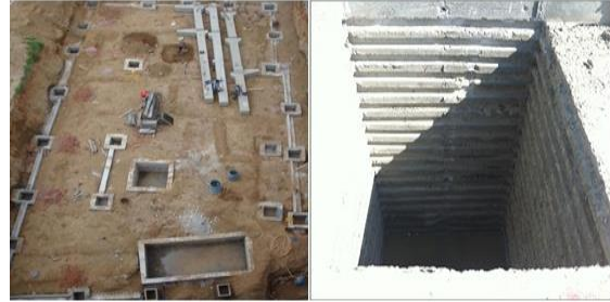
Şekil 2. Kolon için hazırlanmış temel soketleri.
