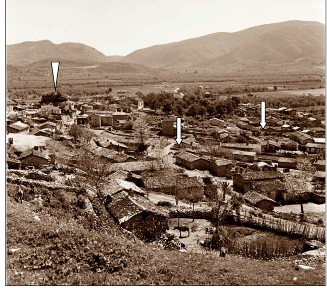
Fotoğraf 14. Ayasuluk-Selçuk Atatürk Mahallesi (1955) 1. Zaviyeli Cami yıkıntıları, 2. Zaviyeli Cami'nin yeri, sol üstte İmaret (Şimdi Ayasuluk Kütüphanesi). / Ayasuluk-Selçuk Atatürk Neighborhood (1955) The ruins of the 1st Zaviya Mosque, the location of the 2nd Zaviya Mosque, İmaret on the upper left (now the Ayasuluk Library).
