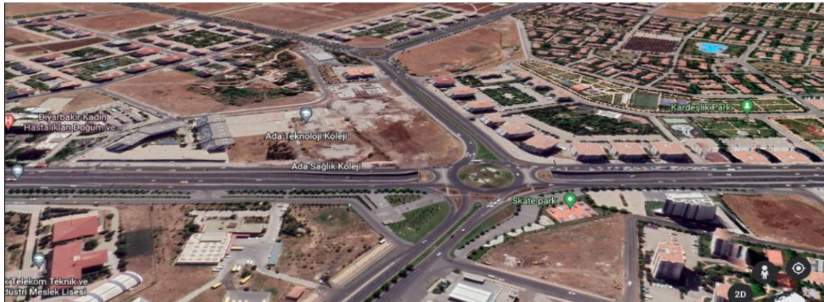
Şekil 2. Diyarbakır Doğum Hastanesi Köprülü Kavşağı alt geçit alanı
