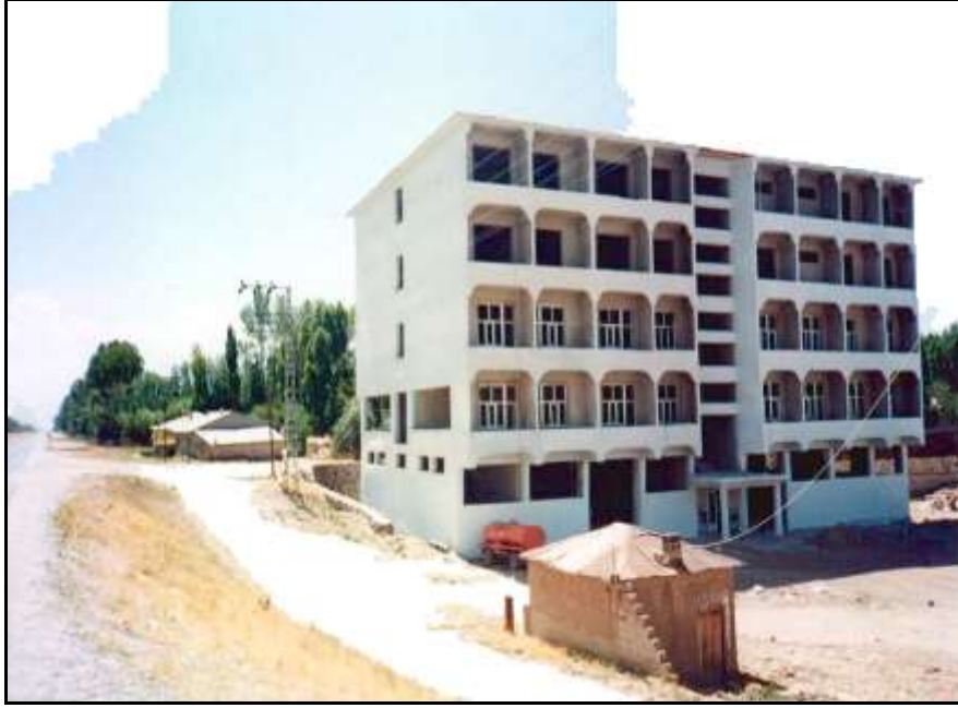
Foto 4: -Erciş'te Otogarın doğusunda inşa edilen Jeotermal Otel binası.
