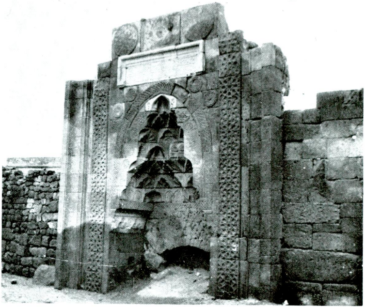
Rs. 1— Ön cephe, kapı tarafı.
