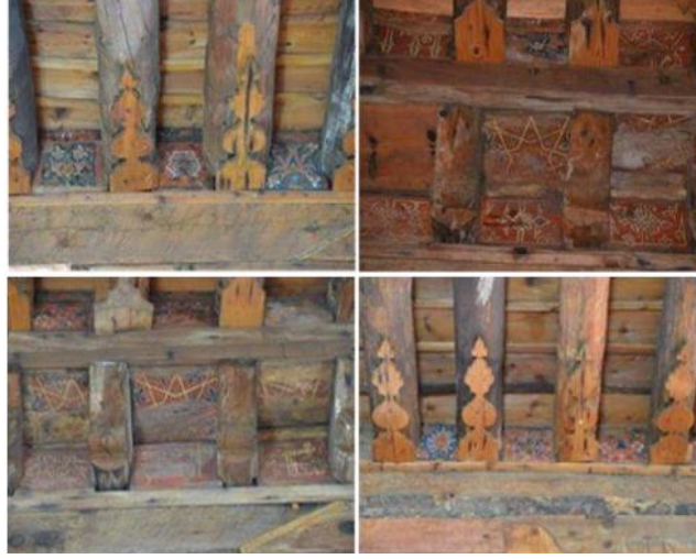
Şekil 6. Afyonkarahisar Ulucami Kiriş Aralarındaki Ahşap Levhalar
