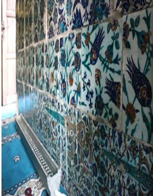
Şekil 28: Sahabeler Türbesi güney Duvarı.
