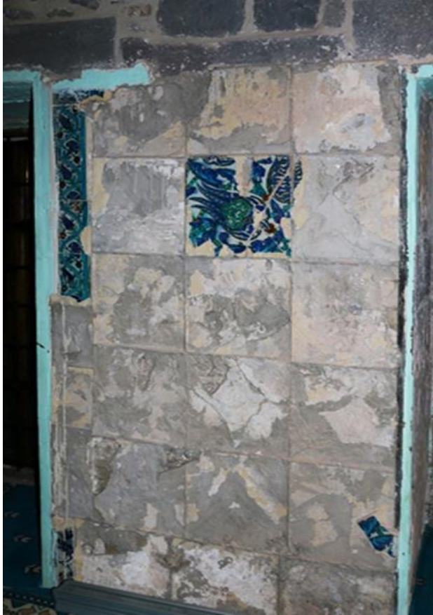
Şekil 6: Sahabeler Türbesi doğu cephesi.
