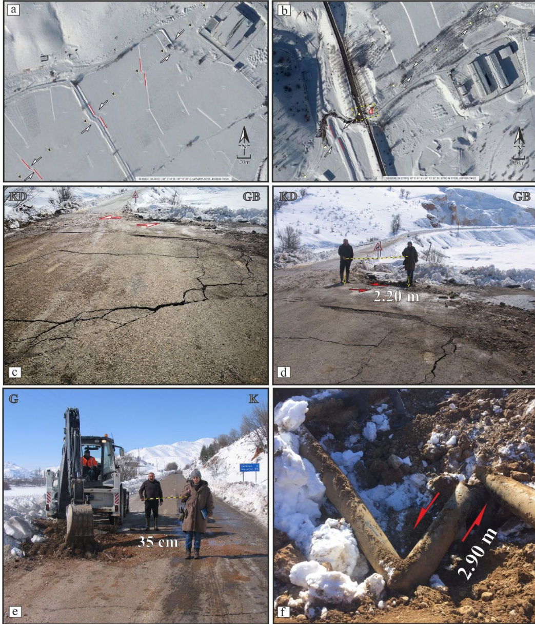
Şekil 2: a,b)Çelikhhan-Adıyaman karayolu üzerinde gelişmiş yüzey kırığının ve ötelenmelerin uydu görünümü üzerinde işlenmiş görünümü, c) yüzey kırığının yolda geliştirdiği deformasyon ve tensiyon çatlakları, d) yol şeridinde ölçülen 2.20 m sol yanar atımın ve ana kırığın gidişi, e) Bulam-3 köprüsünde yol şeridinde 35 cm sol yanar ötelenme, f) çelik su borusundaki 2.90 m sol yanar atımın görünümü Figure 2: a,b) The view on the processed satellite photo of the surface rupture and offsets developed on the Çelikhhan-Adıyaman road, c) deformation and tension cracks formed by the surface rupture on the road, d) 2.20 m left lateral offset measured on the road strip and track major rupture, e) 35 cm left lateral offset in the road lane at Bulam-3 bridge, f) the view of the 2.90 m left lateral offset in the steel water pipe
