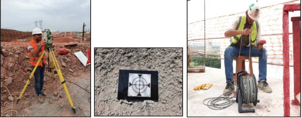
Fotoğraf 6 - Reflektör ve inklinometre ölçüm görüntüleri
