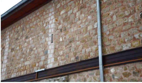
Şekil 3. Taş duvarların kullanımı
