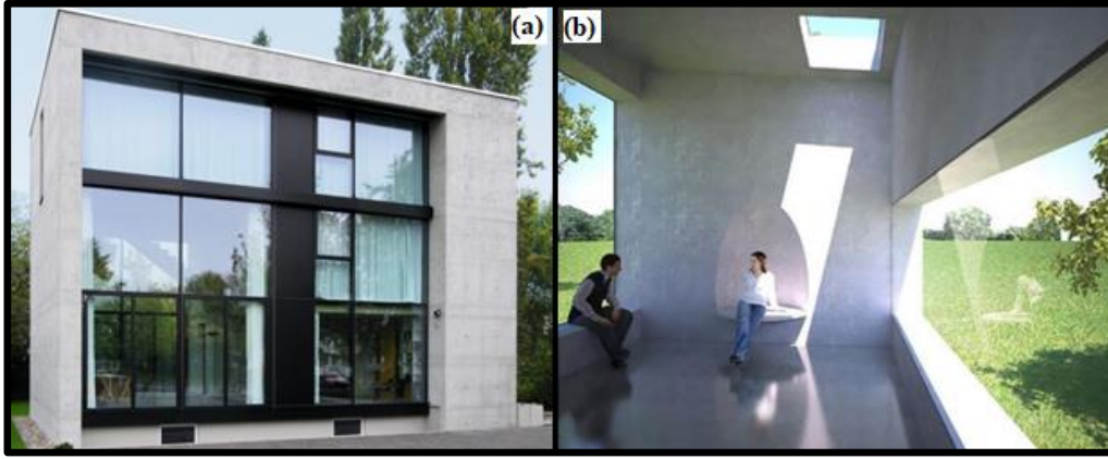
Şekil 3. UHB ile üretilen yapı örnekleri (a- Berlin'deki bir yapı b-Hollanda'daki bir yapı) (theconstructor.org, 2023)
