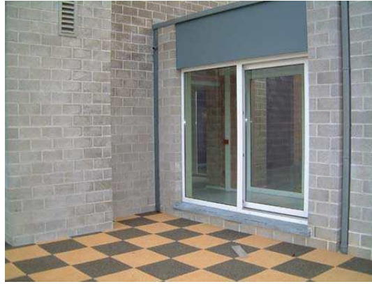
Resim 2. Recyhouse-yağmur oluğu, pencere, duvar ve döşeme kaplaması [17]
