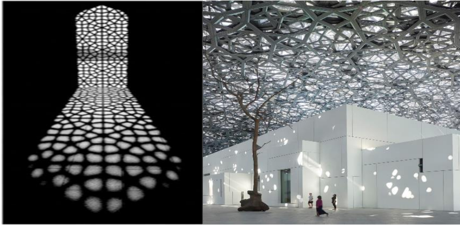
Şekil 4. Louvre Abu Dhabi'nin üst örtüsü, müşrefiye'nin parametrik algoritmalar aracılığı ile yeniden ele alınmasıyla tasarlanmıştır ( Kaynak: Jean Nouvel, 2023).
