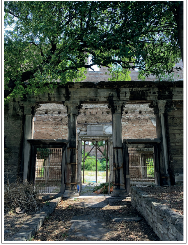
Fotoğraf 5. Studios Manastır Kilisesi atrium bölümünden nartekse bakış (Seda Nur Akbolat 2022) / View of the narthex from the atrium of Studios Monastery Church.
