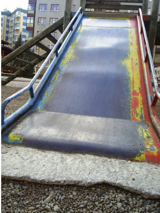
Şekil 26. Nenehatun parkında kum zemininin sıyırılması sonucu beton temeli açığa çıkmış kaydırak detayı (Orijinal 2007).
